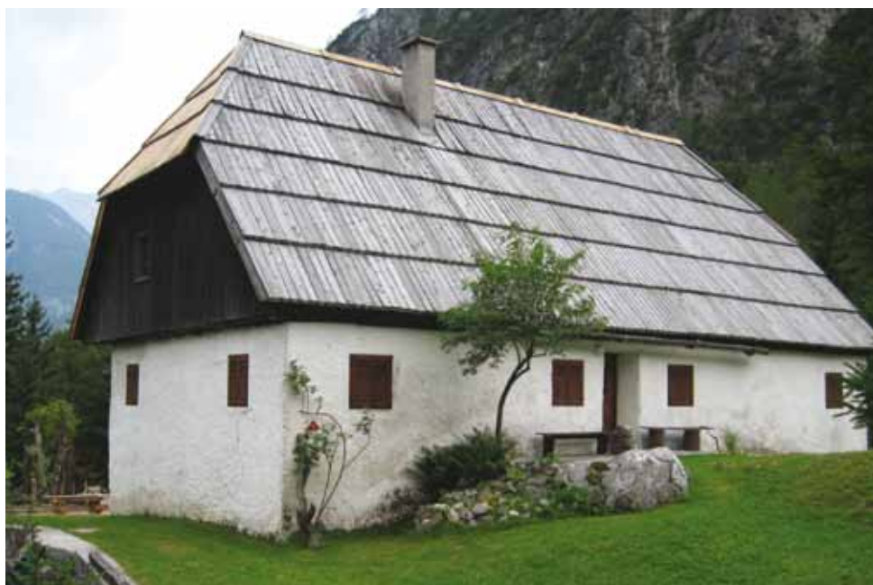
Slika 7. Velika zidana hiša Lepena 68 ima streho prekrito z žaganimi deskami (foto: V. Hazler, 24. 7. 2012).
